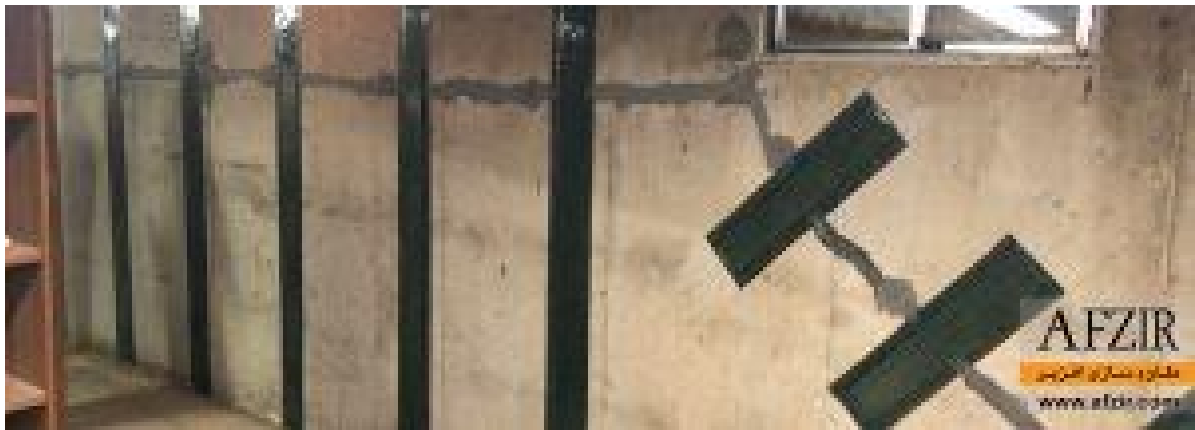
ترمیم ترک با استفاده از کامپوزیت FRP
