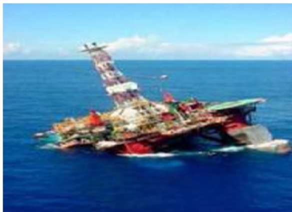
شکل شماره (۱): شکست سکوی دریایی ناشی از عدم تعادل
