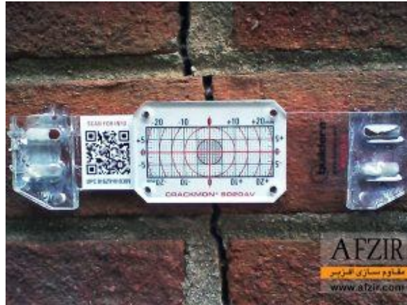
بررسی ترک به روش Plastic Tell Tale
