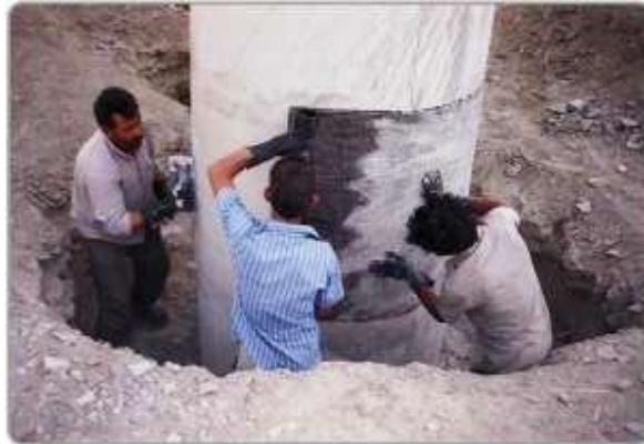
شکل ۷: استفاده از شست الیاف کربن در فرآیند مقاوم‌سازی پایه‌های پل‌های راه‌آهن محور بافق-بندرعباس
