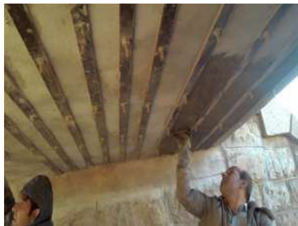
شکل ۸: مقاوم‌سازی دال پل‌های راه‌آهن محور قم به کاشان با استفاده از تسمه فلزی
