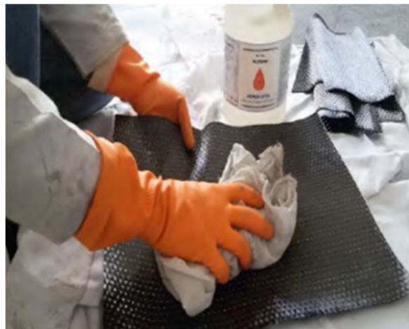
شکل (۳) : تمیز کردن FRP با استفاده از استون
