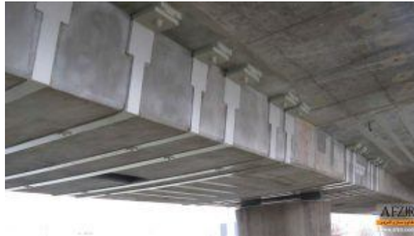
تقویت دال بتنی با ورق فولادی
