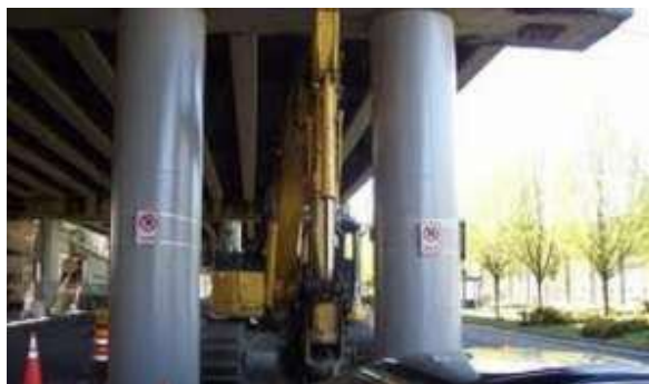
شکل ۲: اجرای روکش ستون فولادی
