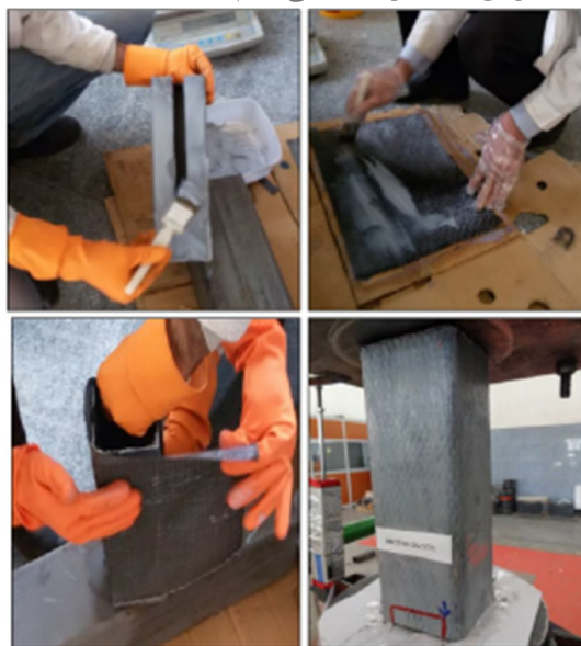
شکل (۶): مراحل چسباندن FRP به نمونه ستون فولادی
