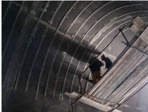
شکل ۹: مقاوم‌سازی لاینینگ بتنی تونل راه تبریز-شیبلی با استفاده از تسمه فلزی
