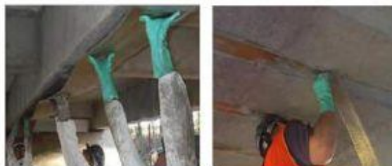
شکل شماره پنج: نصب کامپوزیت‌های SRP برای مقاوم‌سازی تیر پل‌ها
