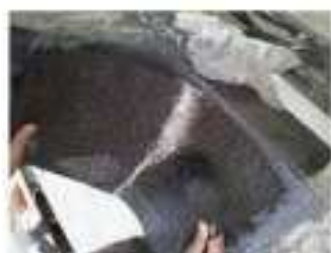
شکل (۴) الیاف FRP به کار برده شده در تقویت اتصال RW1
