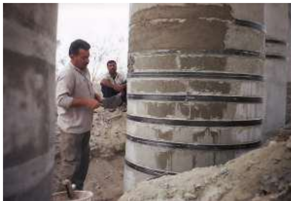
شکل ۶: استفاده از لمینیت الیاف کربن در فرآیند مقاومسازی پایه‌های پل‌های راه‌آهن محور بافق-بندرعباس
