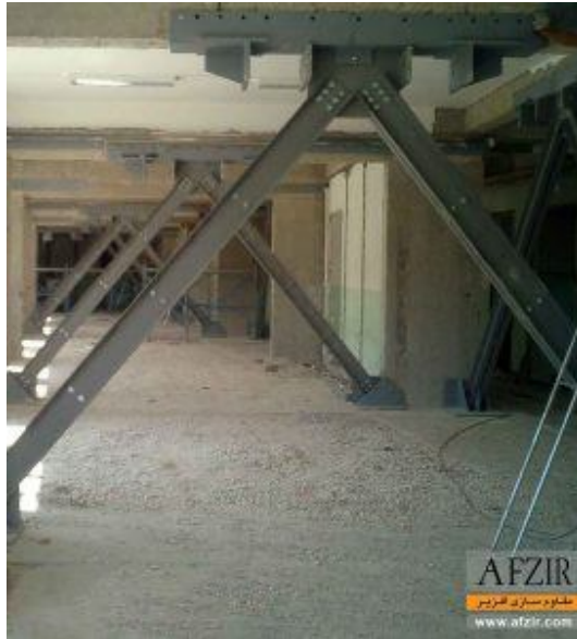
مقاوم سازی ساختمان با افزودن مهاربند فولادی
