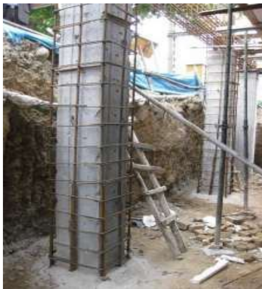
شکل ۱: اجرای روکش ستون بتن مسلح
