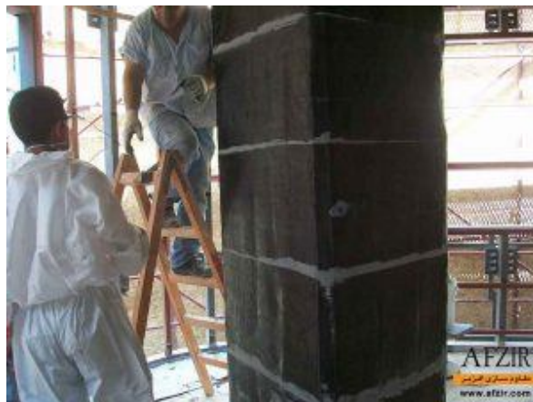
ترمیم ستون بتنی با الیاف FRP
