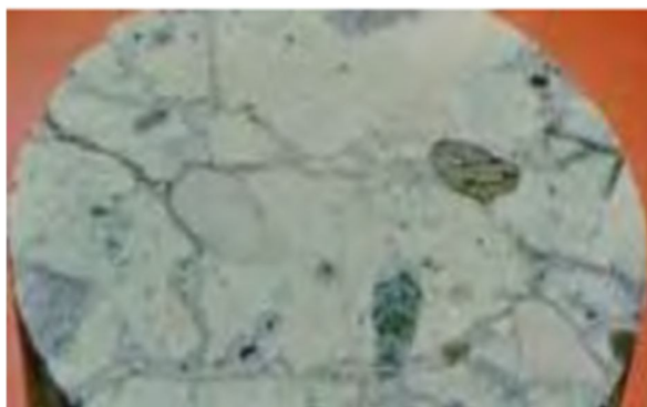
شکل (۱): ترک های کشیده در اطراف سنگدانه ها
