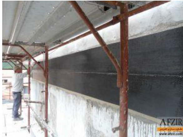
ترمیم دیوار بتنی با الیاف CFRP
